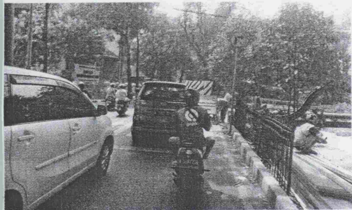
PADAT: Kondisi ruas jalan di lokasi salah satu proyek pembangunan jembatan di Jalan Windu Karya, Tangerang. Dinas PUPR akan mempercepat proyek pembangunan tersebut agar segera selesai.
