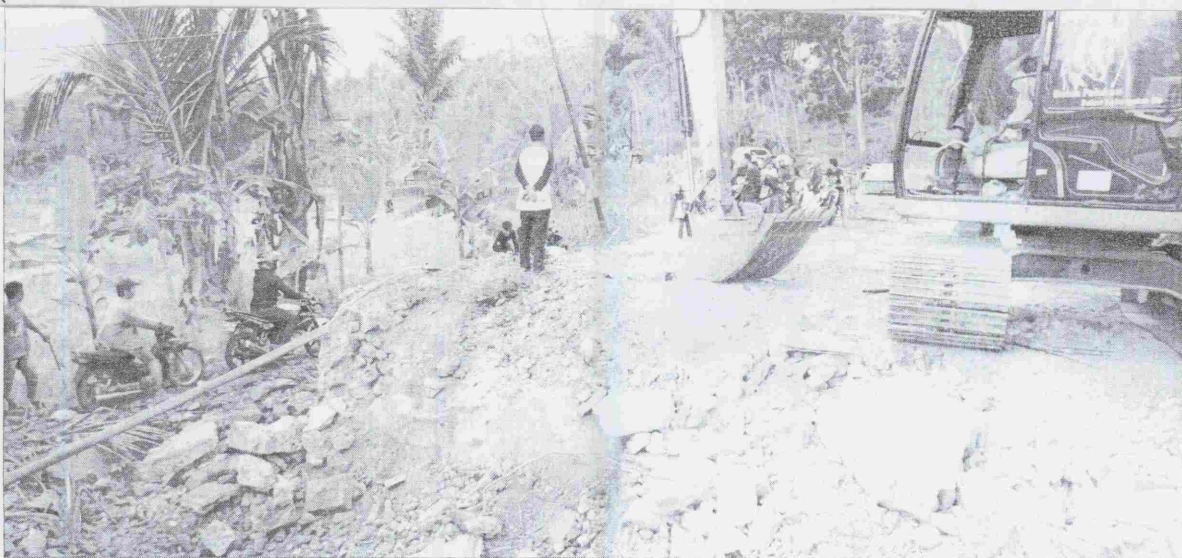
MULAI DIBANGUN: Jembatan Cipajajar yang berada di Desa Cikareo, Kecamatan Cileles, mulai dibangun, kemarin. Proyek ini dibiayai APBD perubahan 2019 senilai Rp637 juta.
