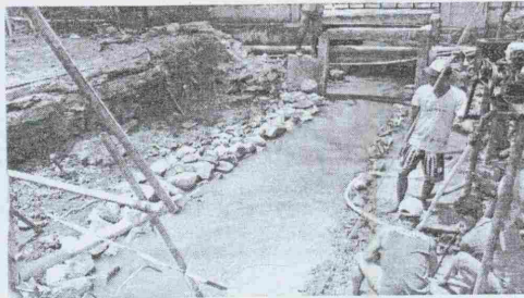
PEKERJA sedang membongkar jembatan di Jalan Teuku Umar untuk ditinggikan.
